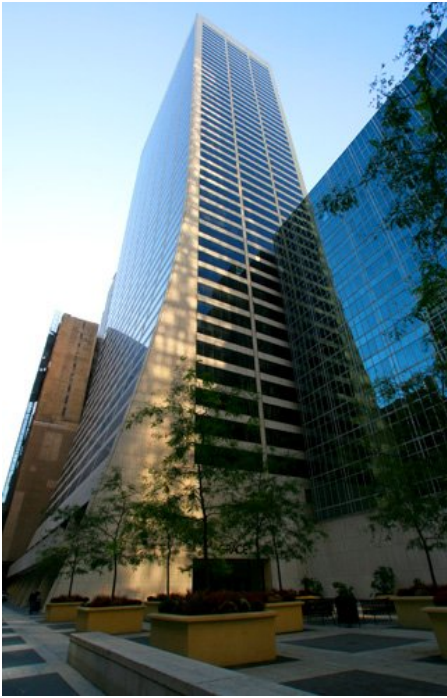
Fig.7 - Il Grace Building di Manhattan (New York ), opera del 1974 del famoso architetto Gordon Bunshaft, cui è ispirata la forma dei telai di copertura dei diffusori GR Delta 4.
